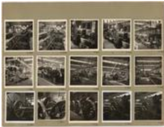
Usine ferroviaire (IP-AV-PC_000185)
